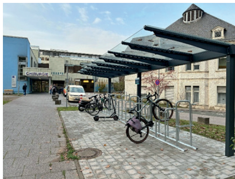
Moderne überdachte Abstellanlage vor Geb. 57
