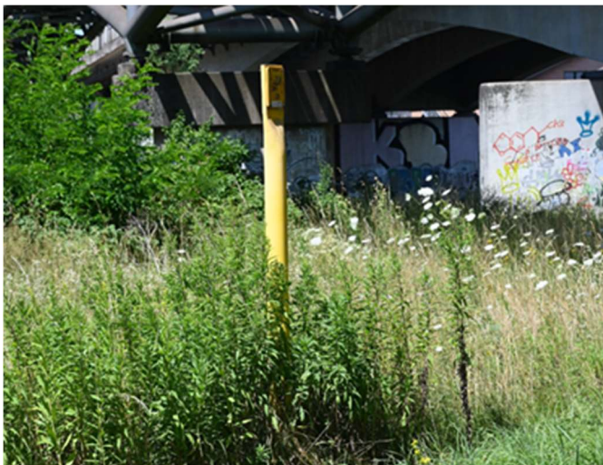
Im Verdichtungsraum an der Saar verlaufen verschiedene Versorgungsleitungen parallel zum Fluss und zur Autobahn
