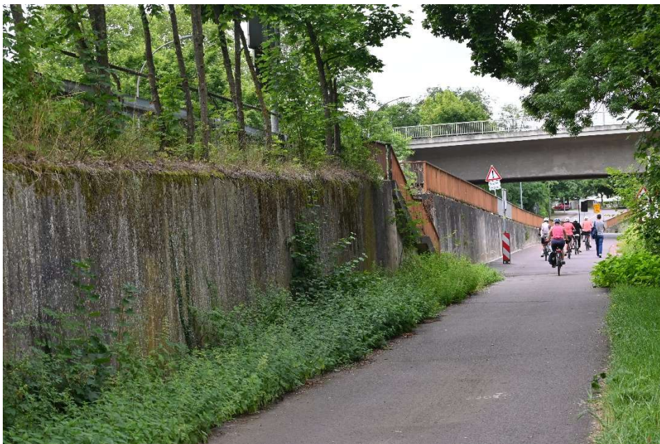
Schmaler, mit Bäumen bewachsener Grünstreifen zwischen einer Stützmauer und der Eisenhütter Allee in Saarlouis.
